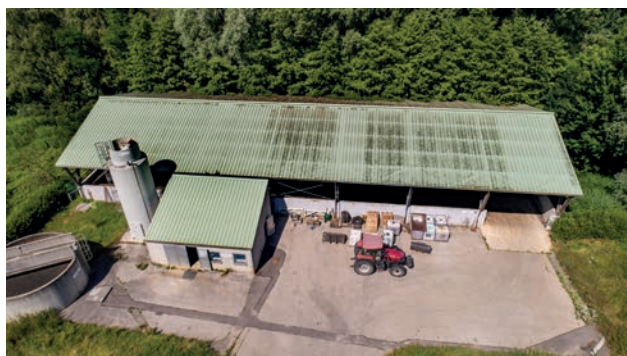
Silo, déshydratation et hangar de stockage des boues de la station de Divonne les Bains
