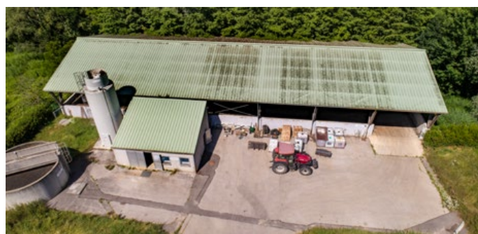
Silo de déshydratation et hangar de stockage des boues de la station de Divonne les Bains
