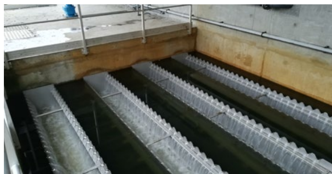
Renouvellement des goulottes du traitement tertiaire de Divonne
