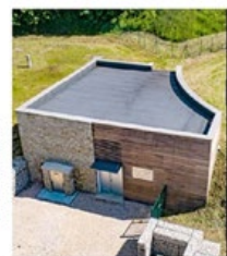
Le réservoir du Chamois, à Gex, a été inauguré en avril 2019. Photo : Pays de Gex agglo
