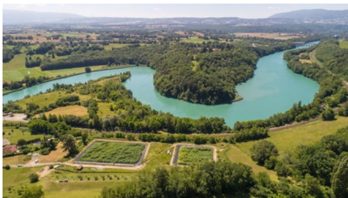
Station à lits plantés de roseaux de Challex
